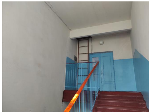
Плохое состояние отделки, которое требует замены
