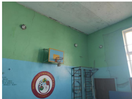
Плохое состояние отделки, которое требует замены
